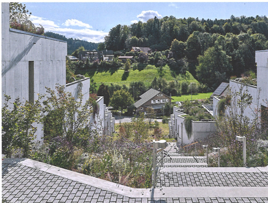
Kaskadenartig und leicht seitlich versetzt bieten die Treppen Ausblick auf Siedlung und Landschaft.
